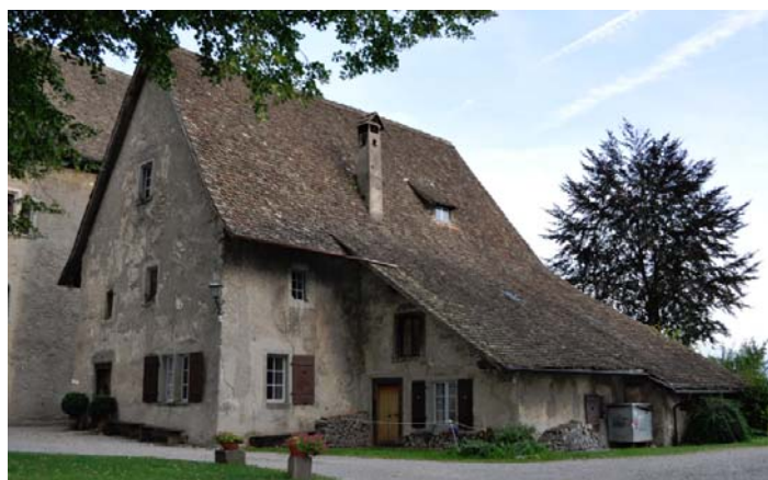
Das Gesindehaus des Ritterhauses soll saniert und für die Öffentlichkeit zugänglich werden
