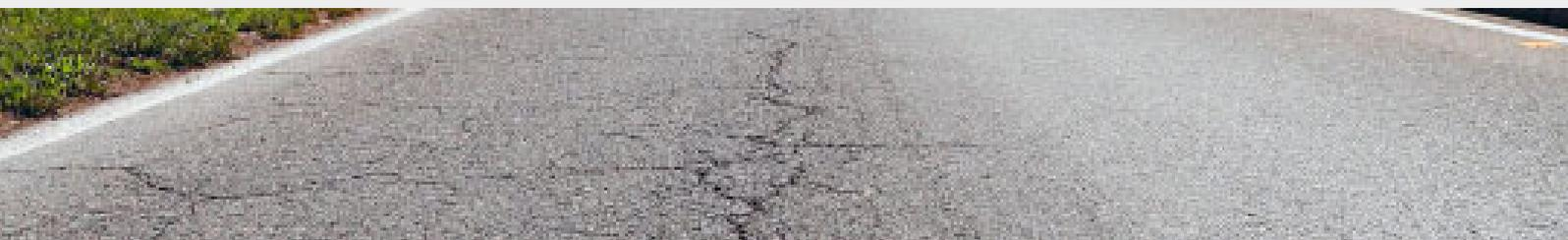
**Beschädigte Fugen und Löcher prägen die neu sanierte Strasse durch das Neeracherried. Dies birgt eine Gefahr für die Verkehrsteilnehmer.**
